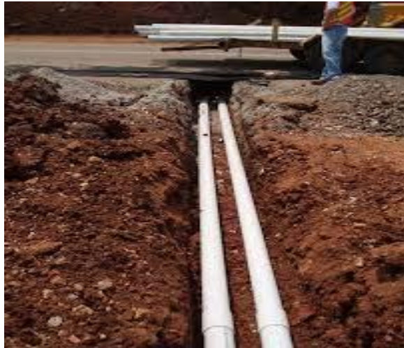
Figure 96 Retrofitted Edge Drains
